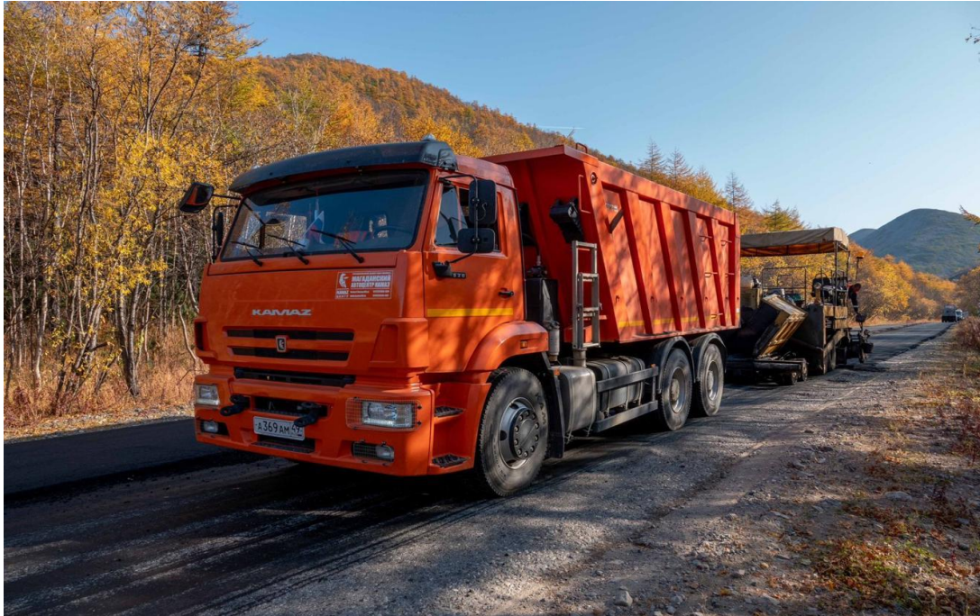
KAMAZ pada pekerjaan jalan
